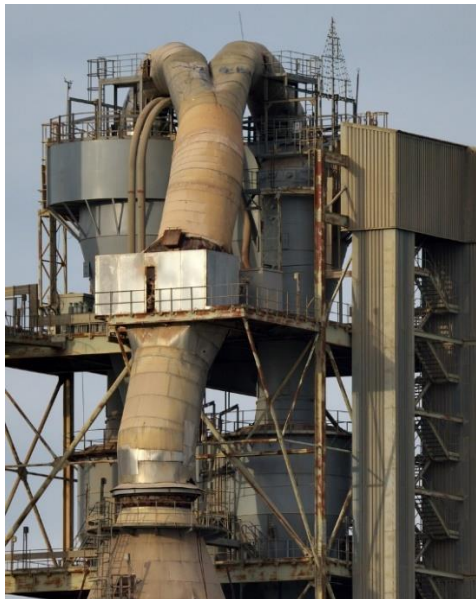
Figura 1. Torre de ciclones de uma fábrica de cimento
